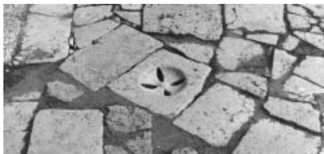
35. Csatorna, javítóaknával az utca burkolata alatt (Aquincum)
